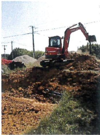
Enfouissement des lignes électriques « la Bréguière »
