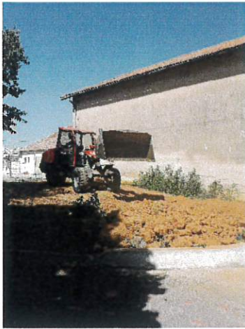
Aménagement (en cours) d'un espace vert devant la cave coopérative
